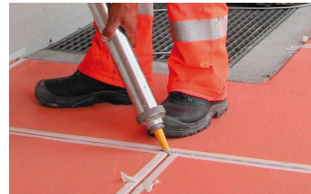
Impermeabilizzazione di giunti
