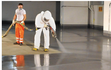
Impermeabilizzazioni con membrane liquide
