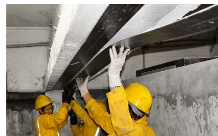
Impermeabilizzazione di giunti
