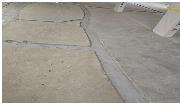
Abgedichtete Risse
