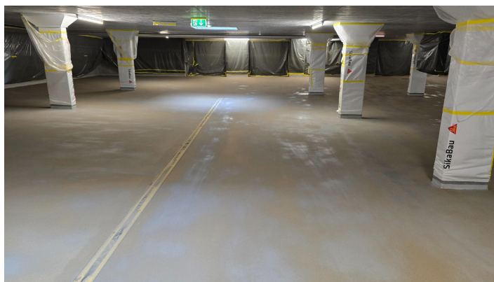
Reprofilierter Hartbeton
