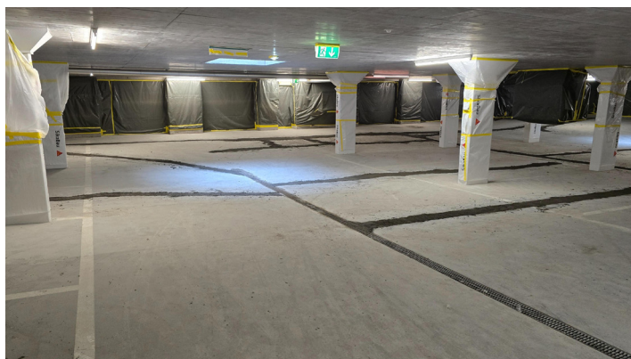
Temporäre Feuchtigkeitssperre
