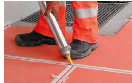
Impermeabilizzazione di giunti
