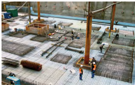
Sistema d'impermeabilizzazione «vasca bianca»
