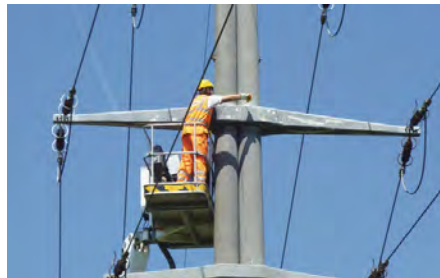
Ripristino e protezione di opere in calcestruzzo
