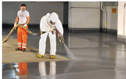
Impermeabilizzazioni con membrane liquide
