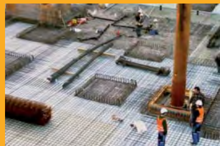
Sistema d'impermeabilizzazione vasca bianca
