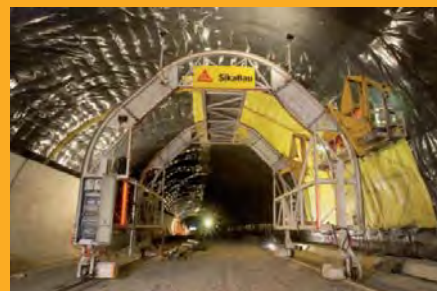
Impermeabilizzazioni di gallerie
