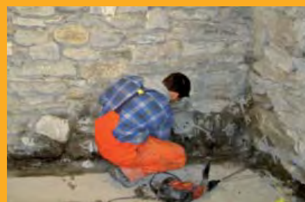
Risanamenti di opere murarie
