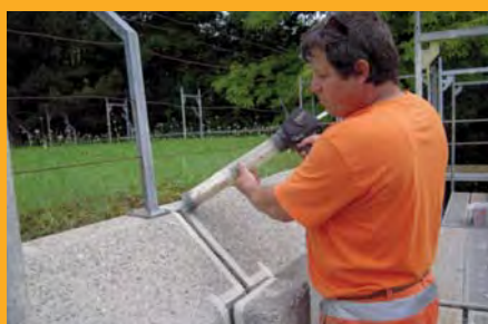
Impermeabilizzazione di giunti
