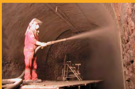
Gunita e calcestruzzo spruzzato
