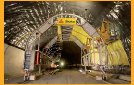
Étanchéités de tunnels
