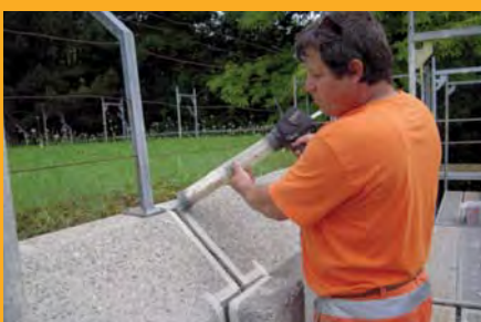
Étanchéités de joints
