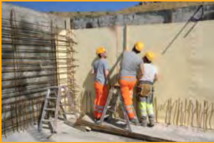
Système d'étanchéité « Cuve jaune »
