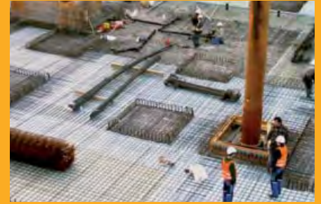
Système d'étanchéité « Cuve blanche »
