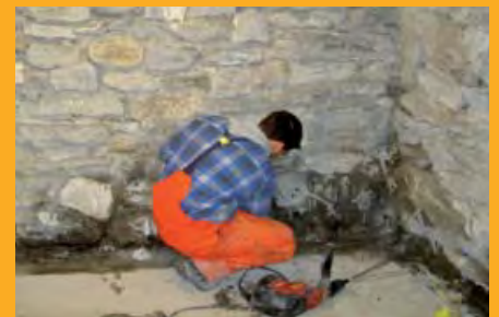
Assainissements de maçonneries
