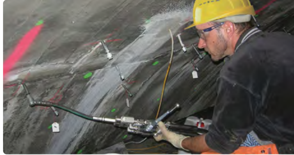
Riss- und Fugeninjektionen
