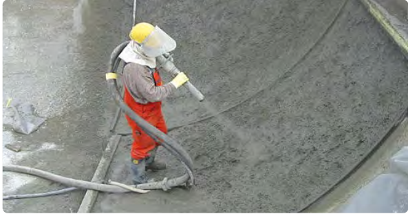
Spritzbeton und Gunite
