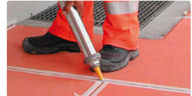
Fugen- und Riss Abdichtungen
