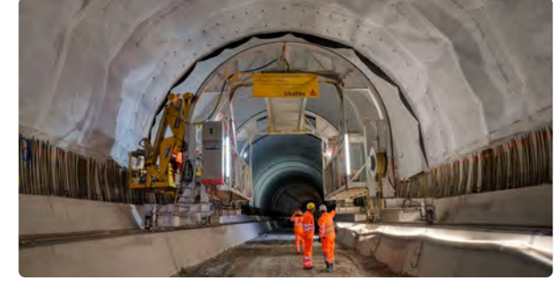
Tunnel Abdichtungen
