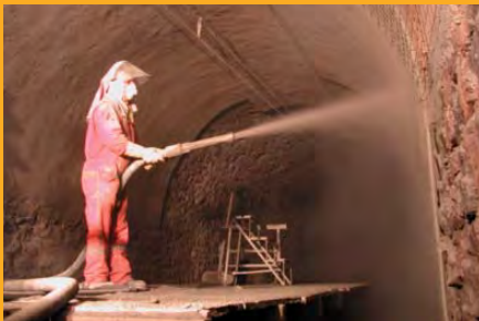
Gunit und Spritzbeton
