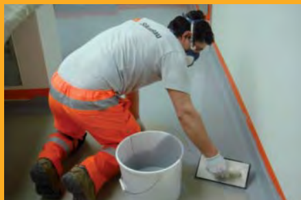
Pavimenti in resina sintetica
