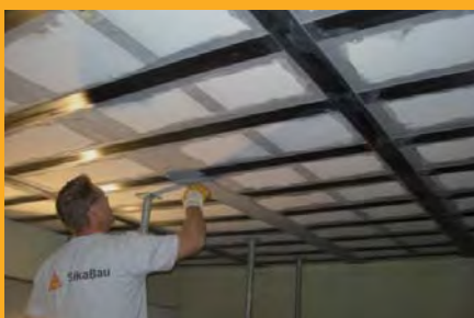
Renforcements statiques
